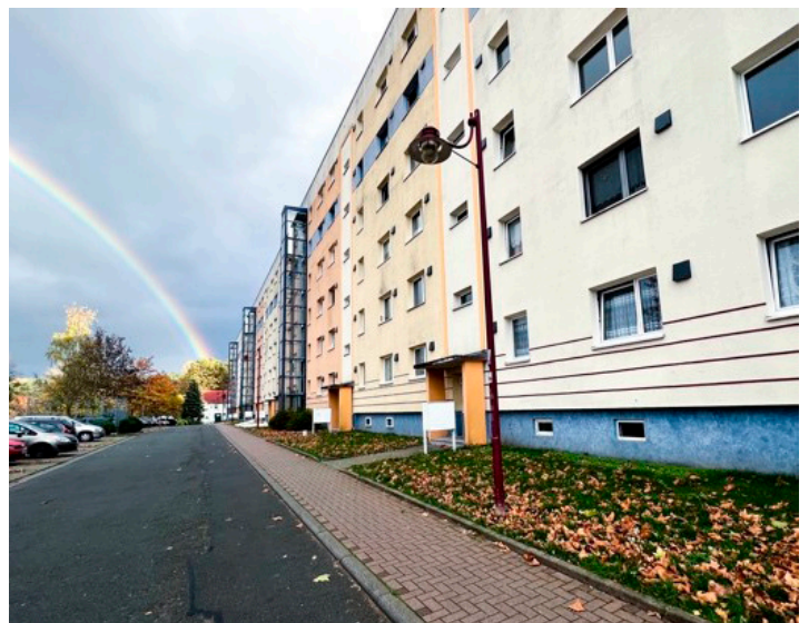
Außenansicht Wohnblock WBS 70
